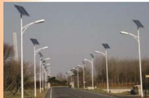
Alumbrado con paneles solares individuales
